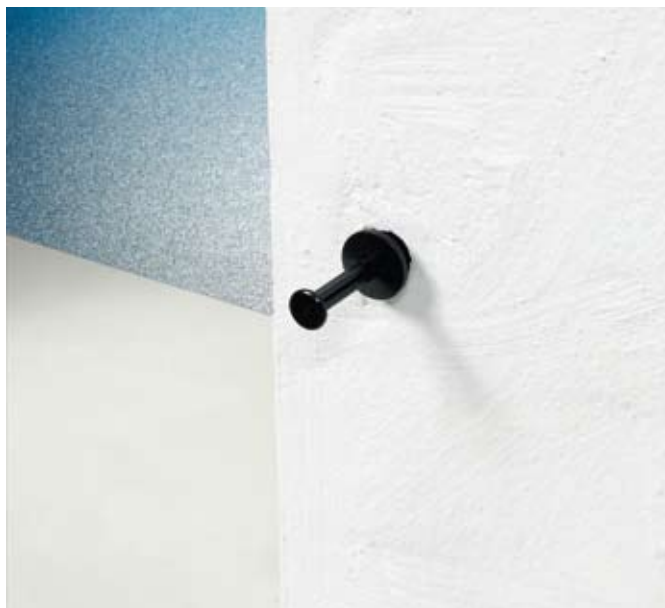
Un tappo chiude il tassello durante la fase di intonacatura
